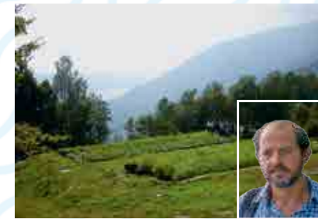
Pflanzenkläranlage in Kärnten/A
